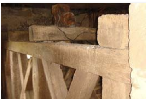
La charpente datée de 1779
